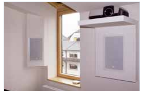
Die Rückseite: Surround- und Surround-Back-Lautsprecher wurden in speziell dafür gefertigten Holzelementen untergebracht
